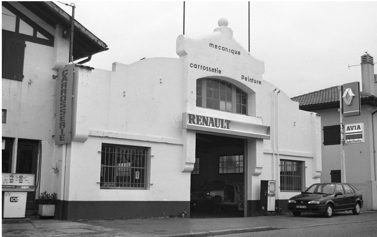
Élévation sur l'avenue d'Espagne, en 1994.
