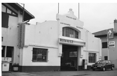
Élévation sur l'avenue d'Espagne, en 1994. Phot. Pierre-Jean Harté-Lasserre IVR72_19996400082Z
