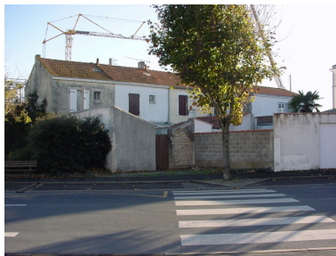
Vue depuis l'avenue Denfert-Rochereau. Phot. Yann Cussey IVR54_20071704352NUCA
