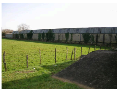
Elévation latérale d'un atelier. Phot. Pascale Moison IVR54_20047906030NUCA
