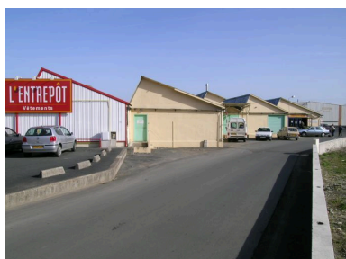
une partie des ateliers vus de l'ouest. Phot. Pascale Moison IVR54_20057900204NUCA
