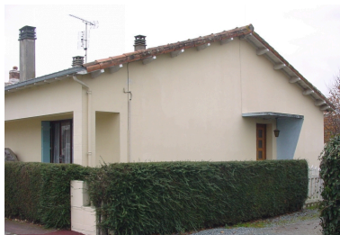
Vue de l'entrée latérale. Phot. Yann Cussey IVR54_20061702002NUCA
