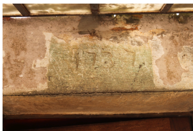
Linteau de porte d'un logis de ferme : 1737 Phot. Line Becker IVR72_20132401009NUC2A
