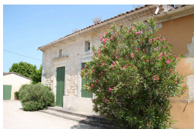
Façade du logis n°3. Phot. Claire Steimer IVR72_20163301626NUC2A
