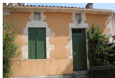
Façade du logis n°2. Phot. Claire Steimer IVR72_20163301625NUC2A
