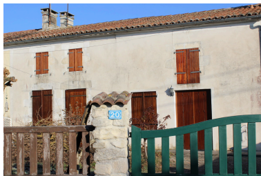
Les façades sur cour des deux maisons, depuis le sud-ouest. Phot. Nathalie Lhuissier IVR54_20171700412NUCA
