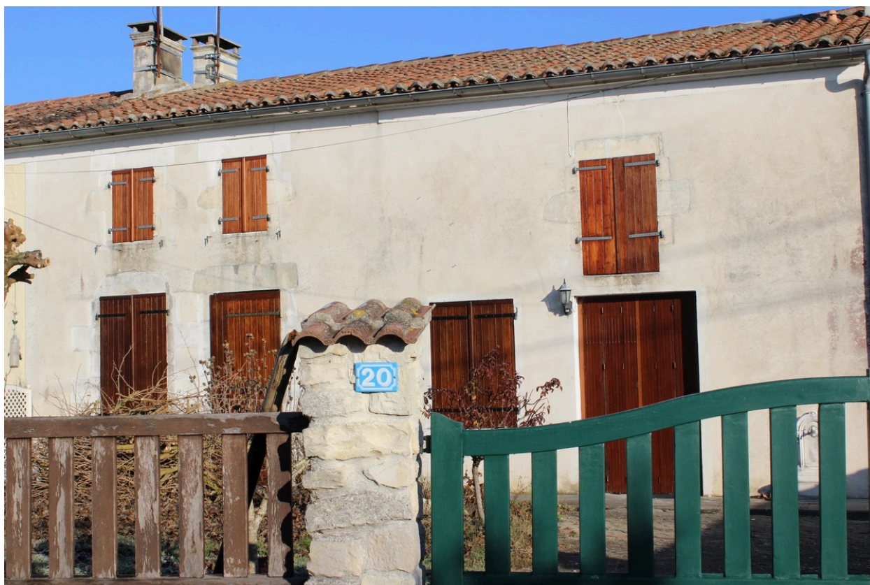
Les façades sur cour des deux maisons, depuis le sud-ouest.
