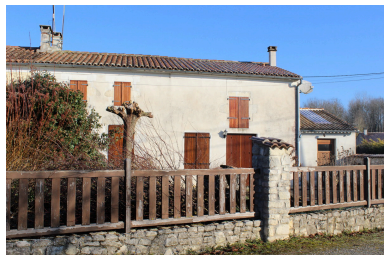
Une vue des deux maisons, depuis le sud-ouest. Phot. Nathalie Lhuissier IVR54_20171700411NUCA
