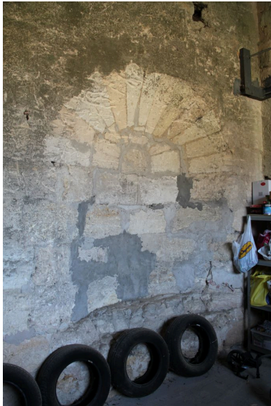
Bâtiment de dépendance, vue intérieure : détail de la niche en pierre de taille.
