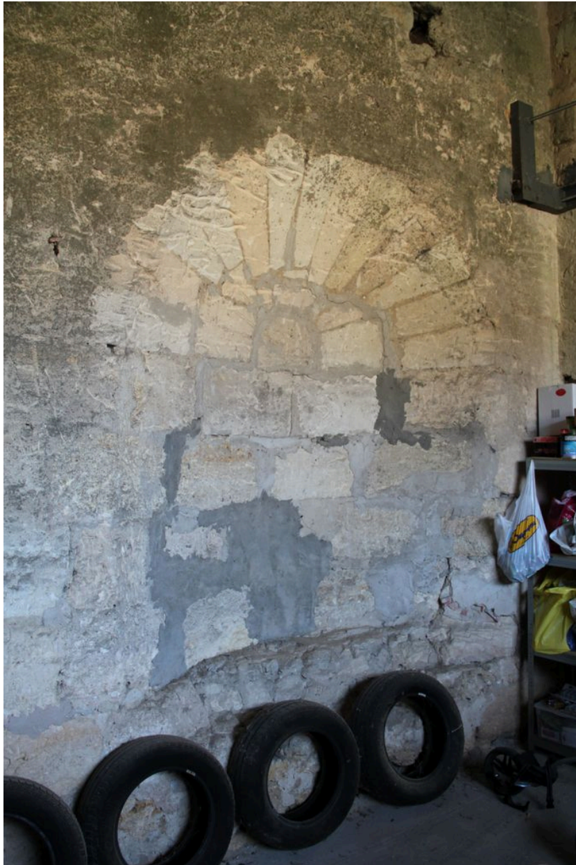
Bâtiment de dépendance, vue intérieure : détail de la niche en pierre de taille.
