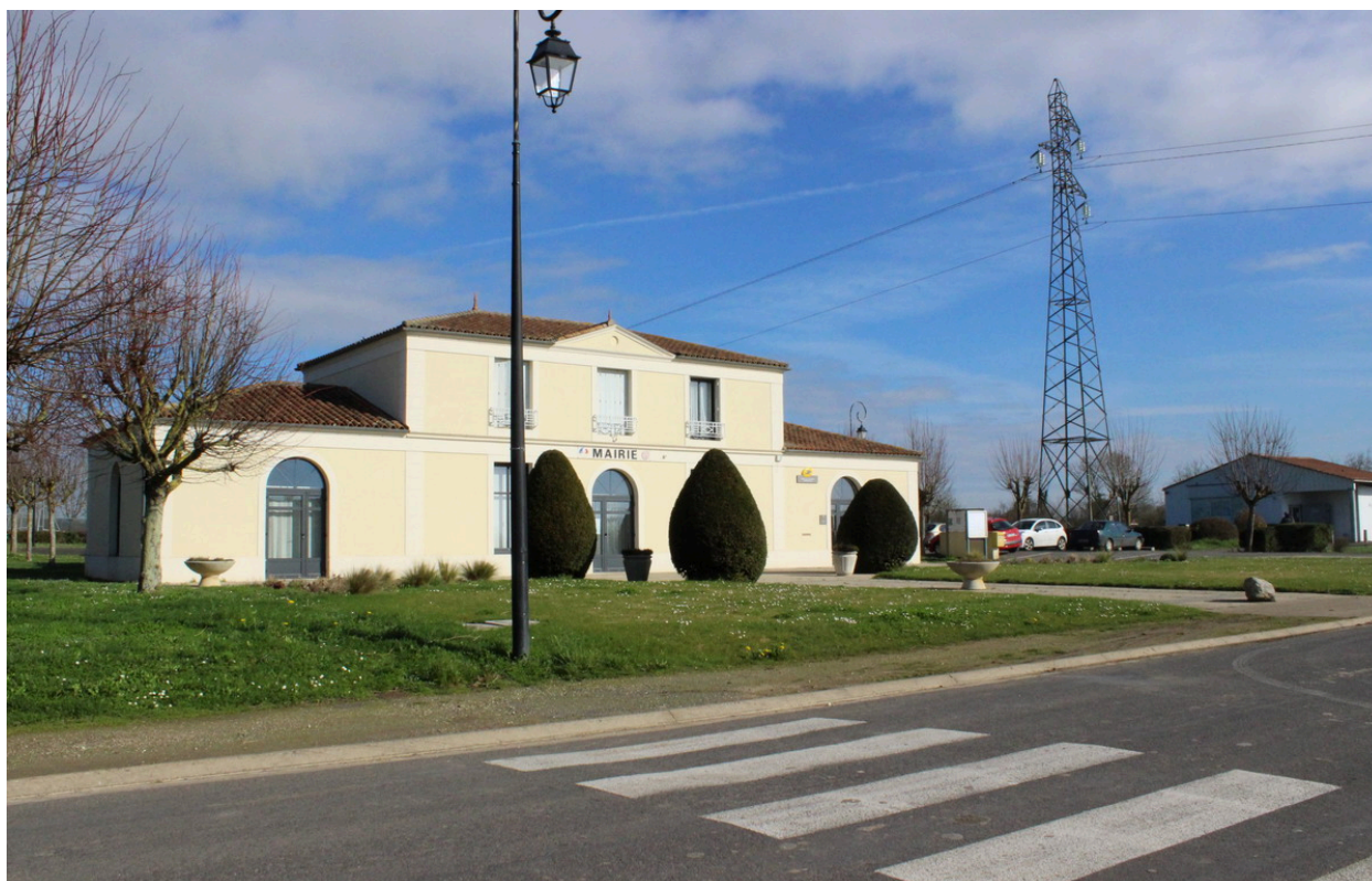
Une vue de la mairie et de la poste, depuis le sud-ouest.
