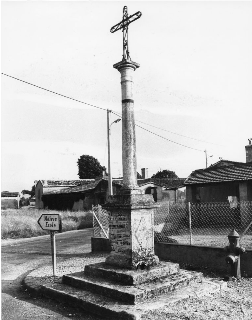
Vue d'ensemble (état en 1974).
