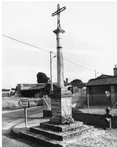
Vue d'ensemble (état en 1974). Phot. Philippe Araguas IVR72_19743301867Z
