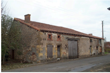
Vue générale. Phot. Yann Ourry IVR54_20041607799NUCA
