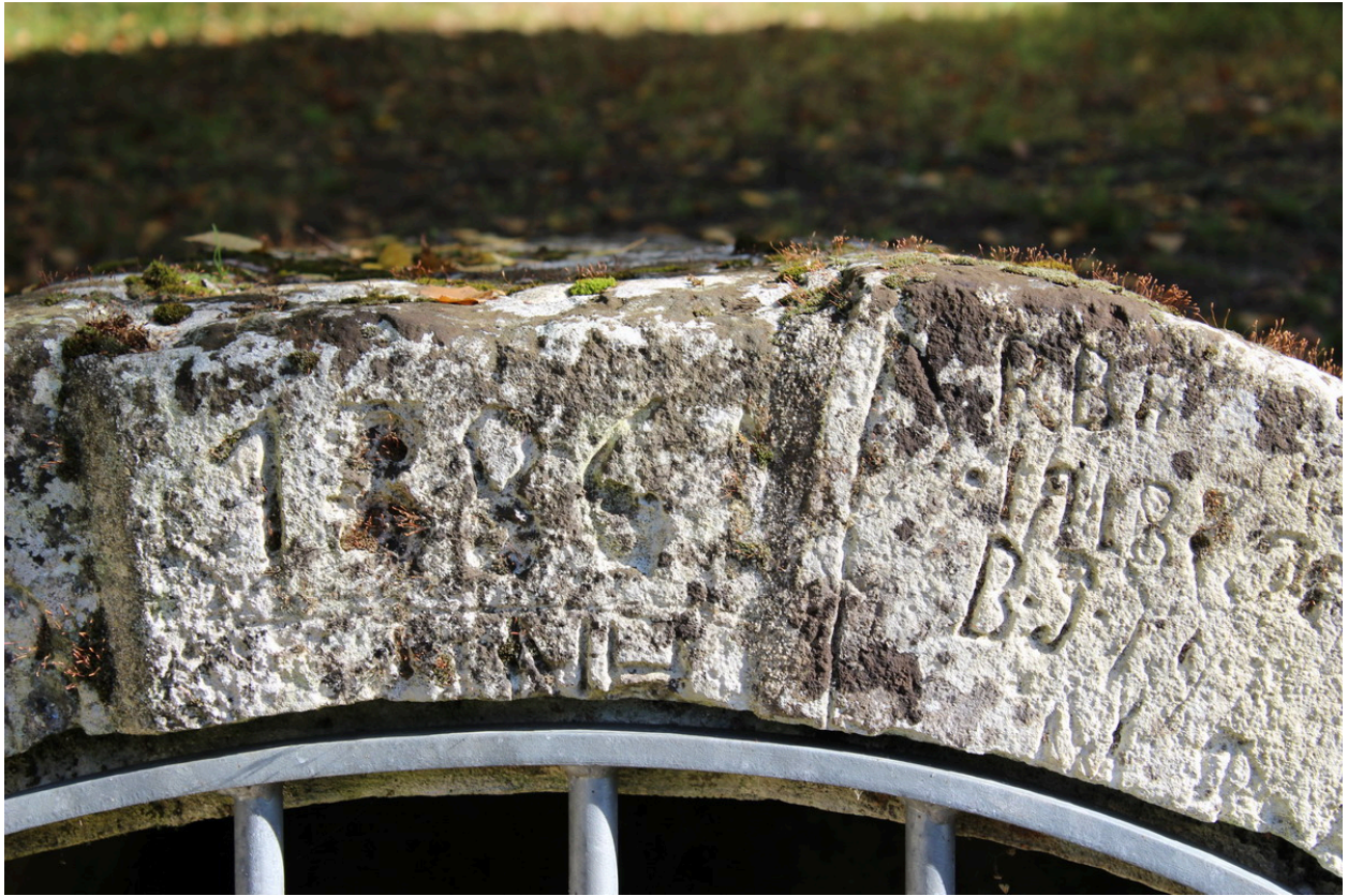
Un détail de la date gravée sur la fontaine, depuis le nord-ouest.
