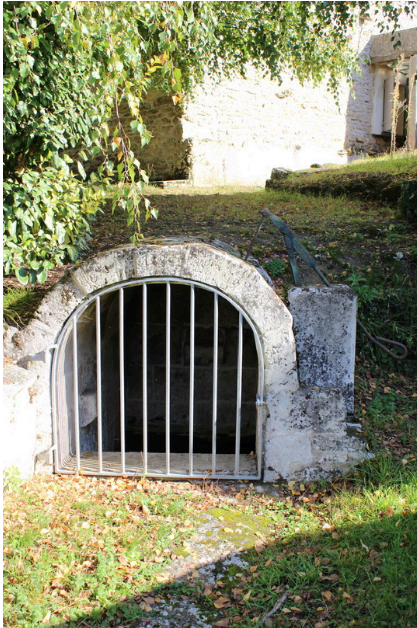
Une vue de la fontaine et du puits, depuis le nord-ouest.
