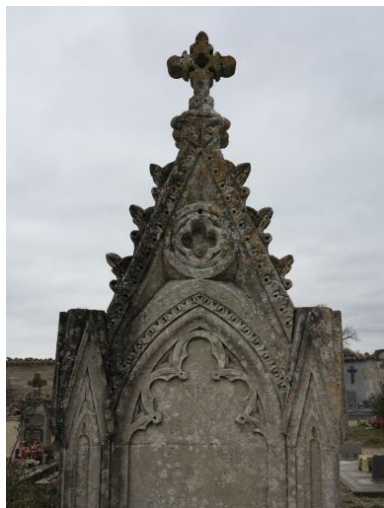
Détail. Phot. Yannis Suire IVR54_20131705698NUCA
