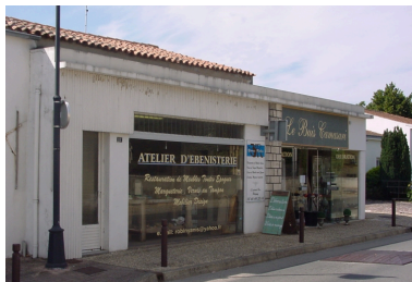
Magasin de commerce (rue de Périgny). Phot. Claire Peyron IVR54_20051702435NUCA
