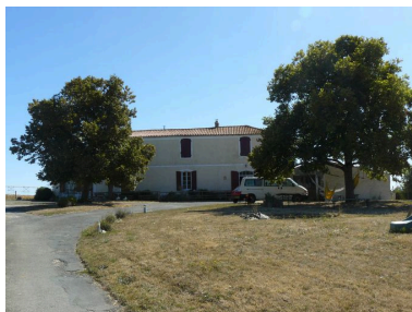
Le logis du Fresne, depuis le nord-ouest. Phot. Mathieu Bordes IVR54_20091701726NUCA
