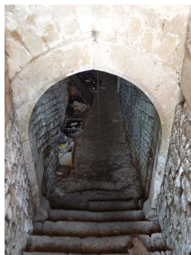
L'entrée du souterrain, depuis le sud-ouest. Phot. Mathieu Bordes IVR54_20091701727NUCA
