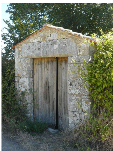
La construction qui abrite l'entrée du souterrain, depuis le sud-ouest. Phot. Mathieu Bordes IVR54_20091701728NUCA
