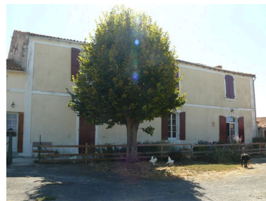
La façade sur cour du logis, depuis le nord-ouest. Phot. Mathieu Bordes IVR54_20091701732NUCA
