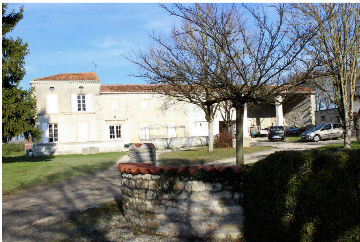
Une autre vue du corps principal de l'ancienne ferme, depuis le sud.
