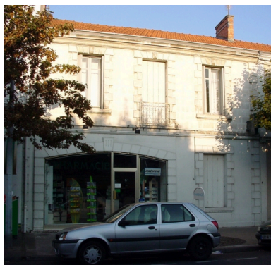
Vue générale. Phot. Claire Peyron IVR54_20041706060NUCA
