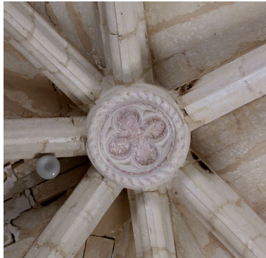
Clef de l'abside. Phot. Jean-Philippe Maisonnave IVR72_20144001130NUC2A
