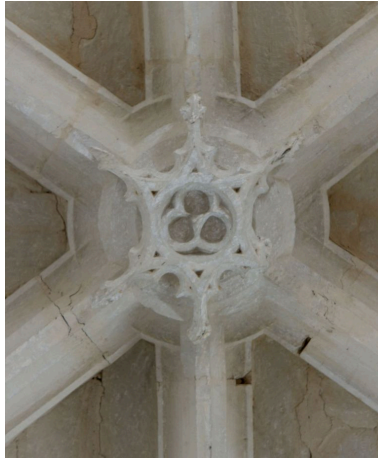
Clef de la 2e travée de la nef. Phot. Jean-Philippe Maisonnave IVR72_20144001127NUC2A
