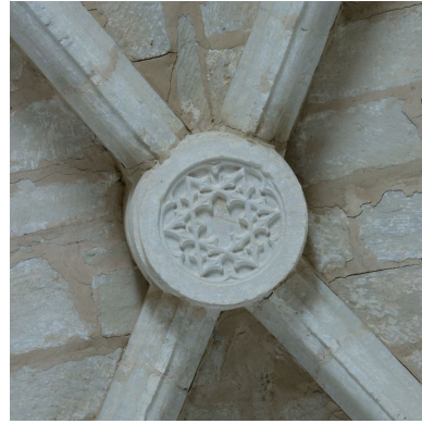
Clef de la 3e travée de la nef. Phot. Jean-Philippe Maisonnave IVR72_20144001128NUC2A
