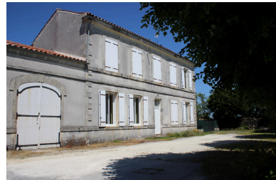
Une vue de l'ancienne école, depuis le sud-ouest. Phot. Nathalie Lhuissier IVR75_20191701923NUCA
