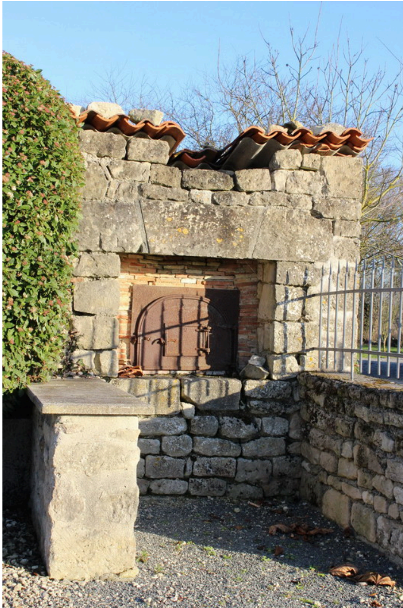
Une vue du four, depuis nord-ouest.
