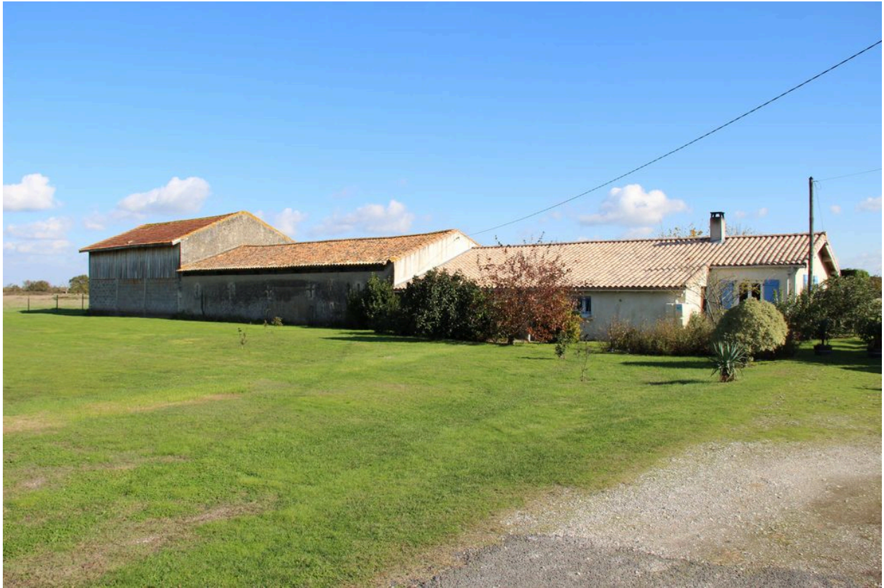
Vue d'ensemble (façades postérieures depuis la route).
