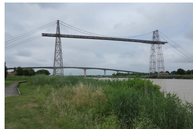
Le pont transbordeur et le viaduc. en arrière-plan. Phot. Pascale Moisson IVR54_20171704584NUCA
