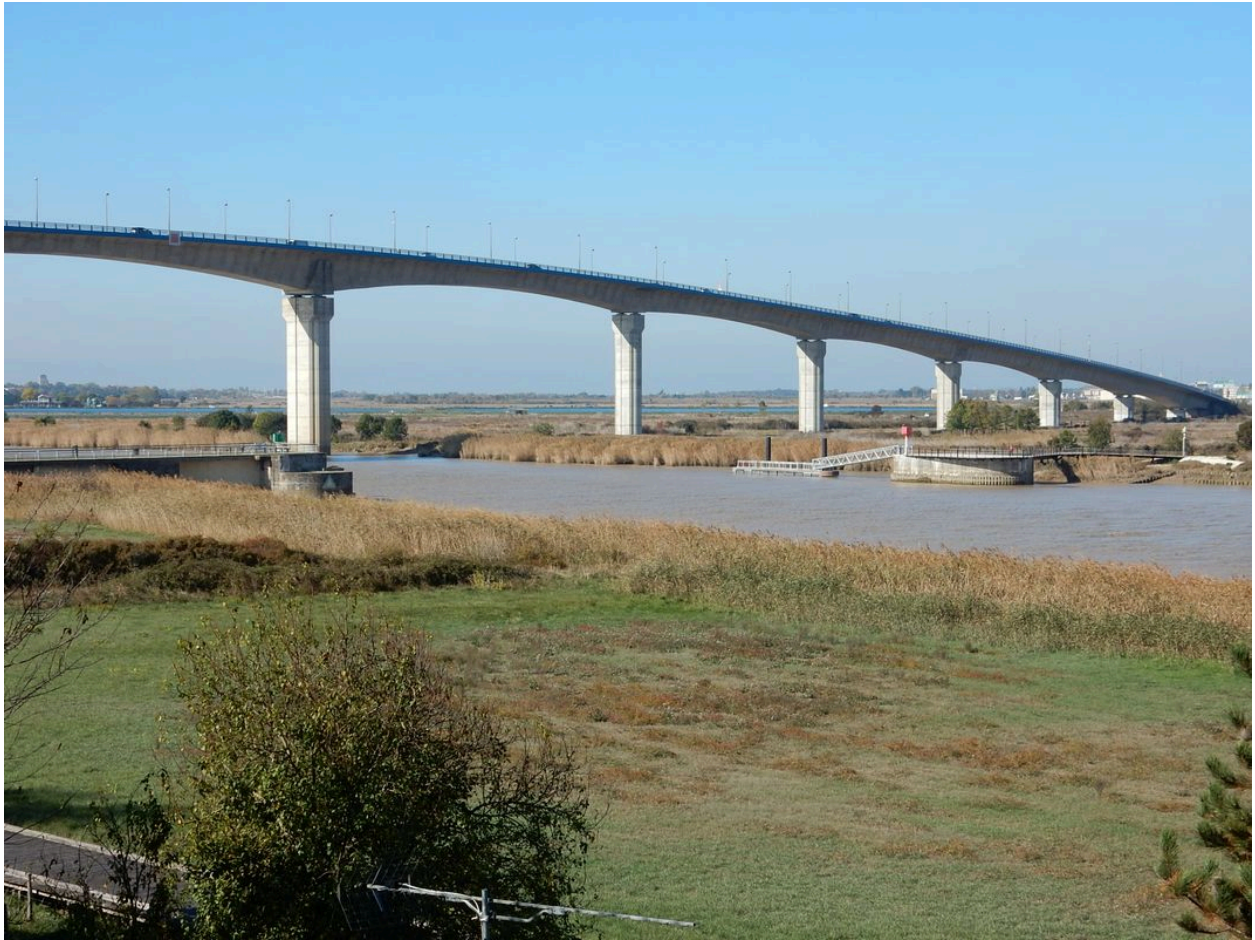
Le viaduc et les vestiges du pont à travée levante.
