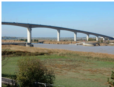
Le viaduc et les vestiges du pont à travée levante. Phot. Pascale Moisson IVR54_20171704147NUCA
