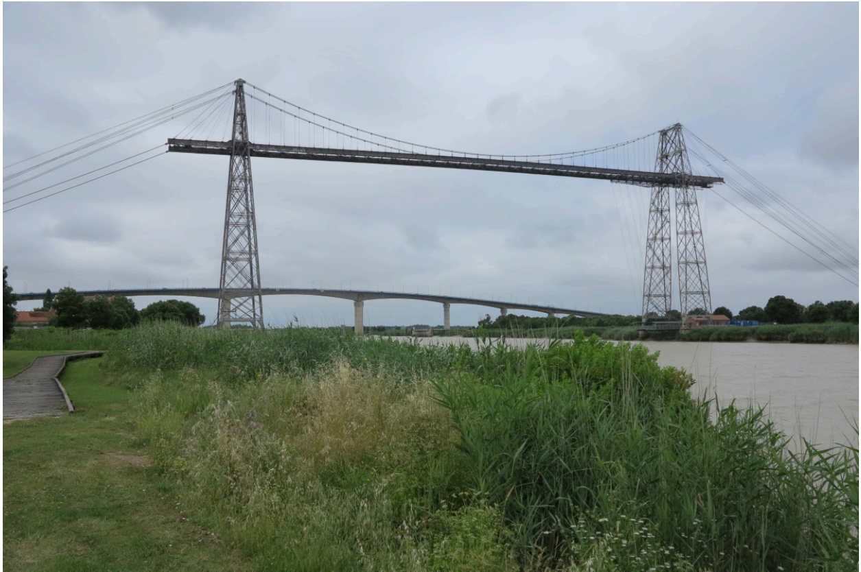
Le pont transbordeur et le viaduc. en arrière-plan.
