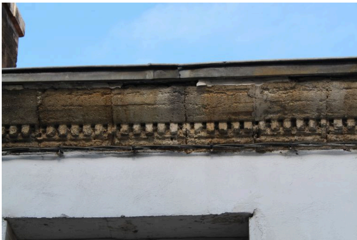
Détail de la corniche.
