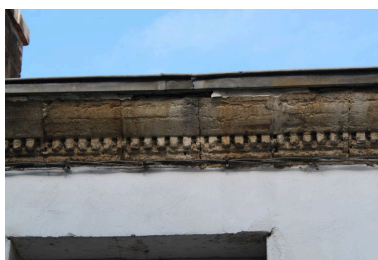
Détail de la corniche.
