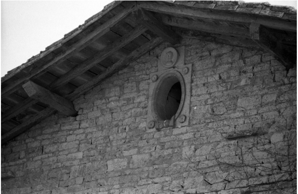
Un détail de l'oculus sur un pignon, depuis le nord-ouest, 1990.
