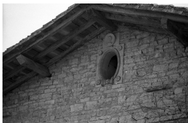
Un détail de l'oculus sur un pignon, depuis le nord-ouest, 1990.
