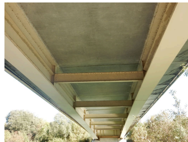
Dessous du tablier. Phot. Pascale Moisdon IVR54_20171704673NUCA
