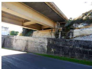
Culée de la rive gauche. Phot. Pascale Moisdon IVR54_20171704687NUCA
