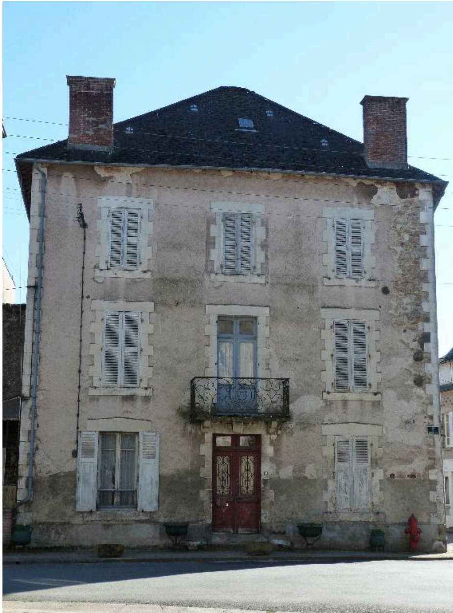
Façade nord de l'ancien hôtel.
