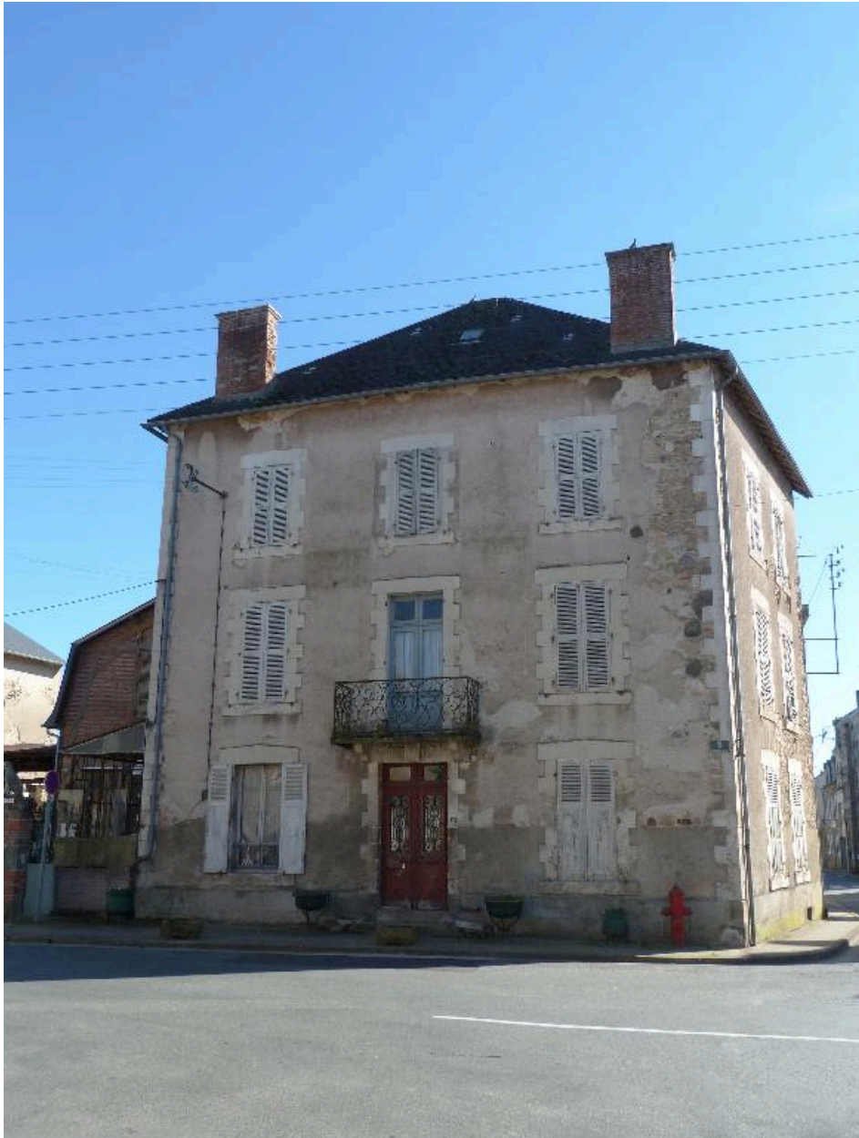
Vue général de l'ancien hôtel.
