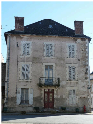
Façade nord de l'ancien hôtel. Phot. Eglantine Pacquot IVR75_20172306031NUCA
