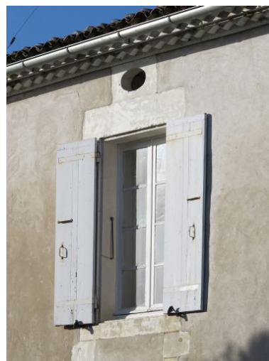
Détail. Phot. Yannis Suire IVR54_20131705348NUCA
