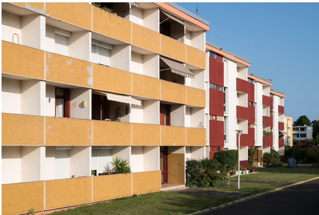
Façades est des barres J du lotissement concerté dit Biscarrosse-Bourg 4.
