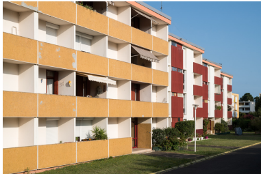
Façades est des barres J du lotissement concerté dit Biscarrosse-Bourg 4. Phot. Adrienne Barroche IVR72_20194010612NUC4A
