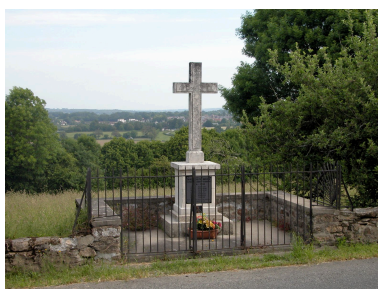
Vue générale du monument aux morts du Puy Brévier. Phot. Céline Belzic IVR74_20082307695NUCA
