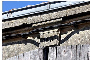
Baie de décharge : agrafe portant la date de 1876.
