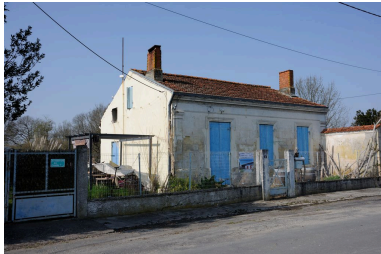
Vue d'ensemble depuis le sud. Phot. Caroline Bordes IVR72_20153300147NUC2A
