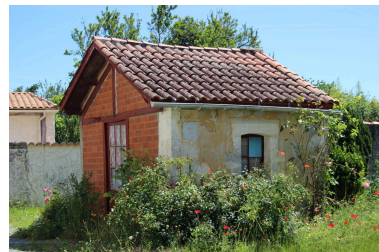
Une vue de la dépendance en face de la maison, depuis le nord-ouest. Phot. Nathalie Lhuissier IVR75_20191701863NUCA
