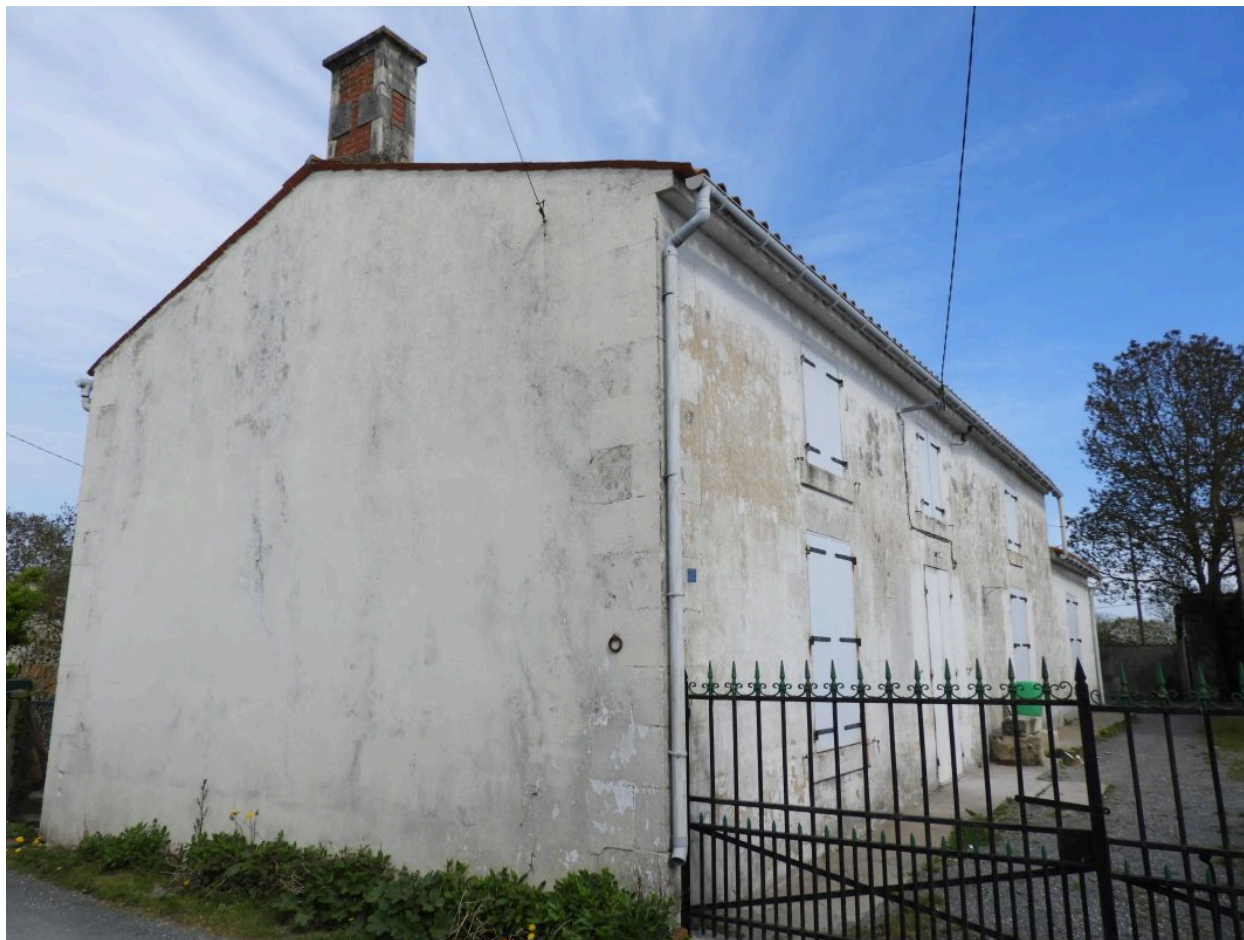
Maison, 7 rue de la Toison d'Or.
