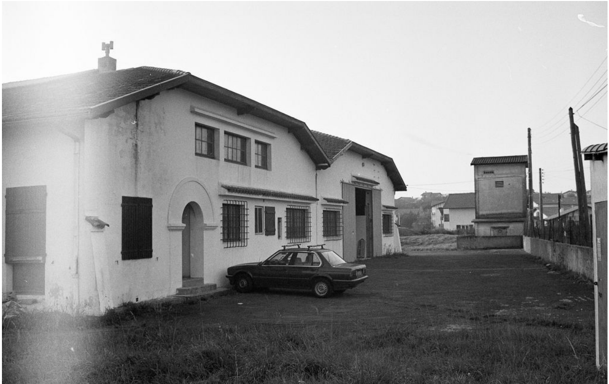
Elévation nord en 1994.
