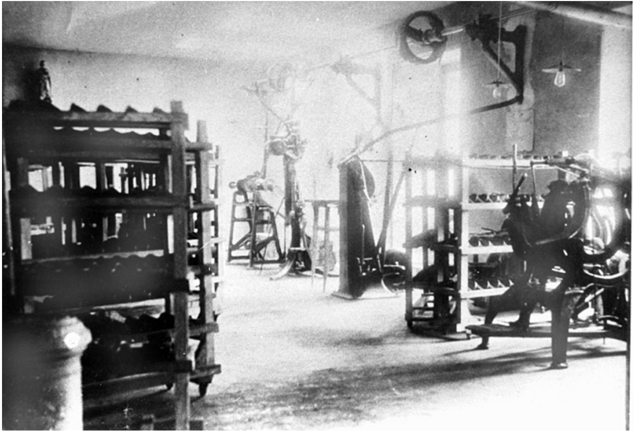
Vue intérieure d'un atelier.
