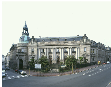
Vue de la façade de la préfecture de Limoges. Phot. Philippe Rivière IVR74_19988700761VA
