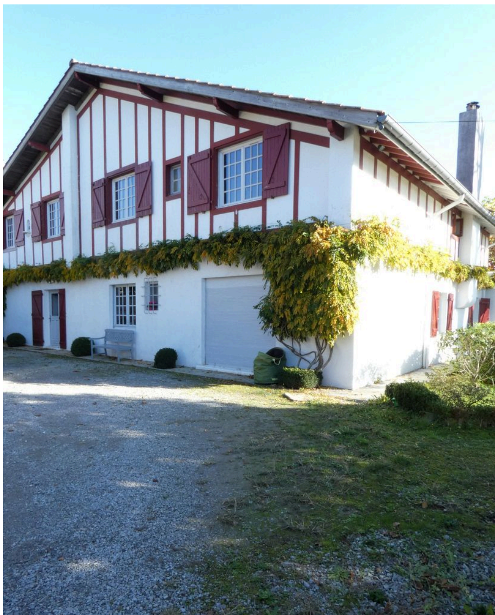
Vue de la façade nord et de la cour.
