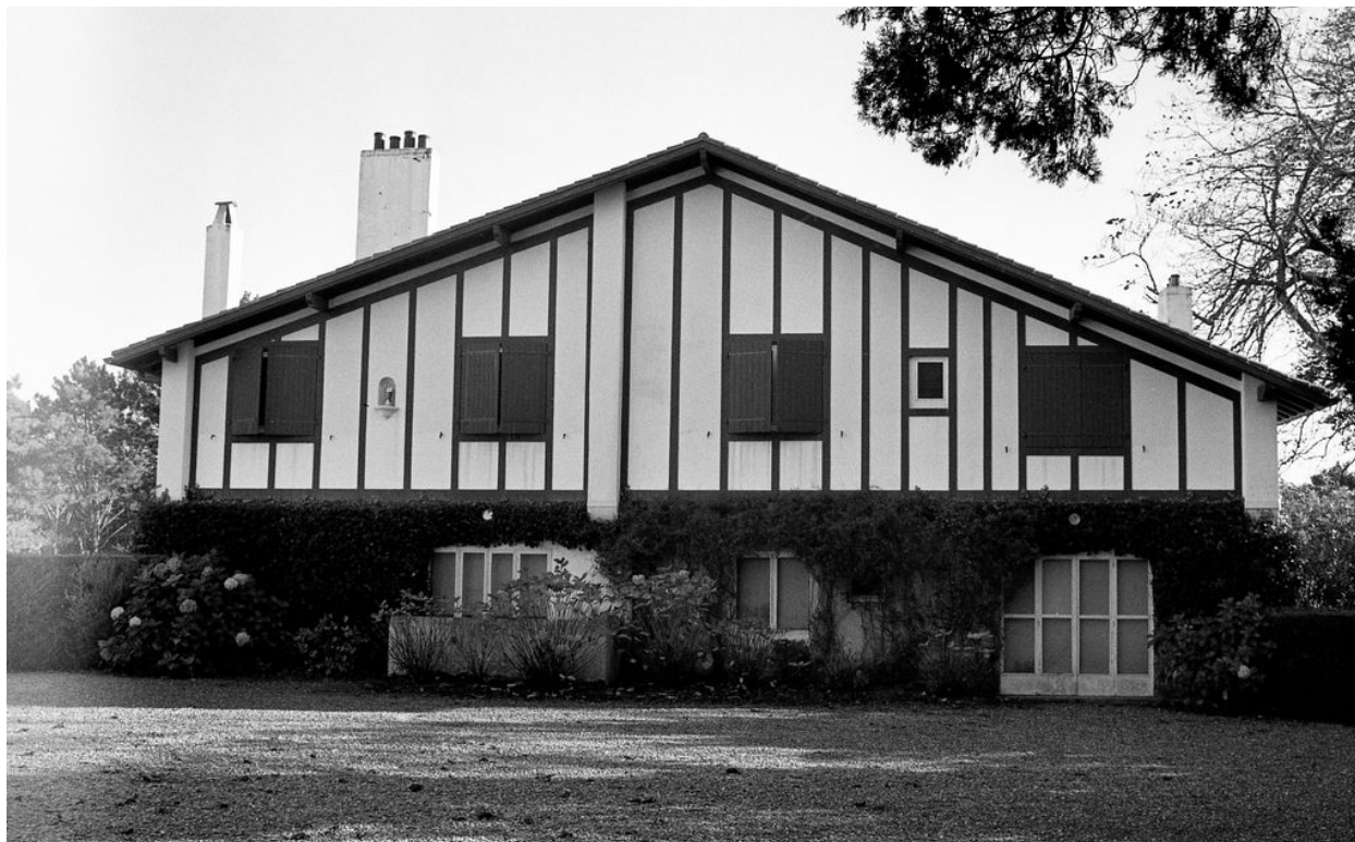
Vue de la façade principale modifiée, en 1994.
