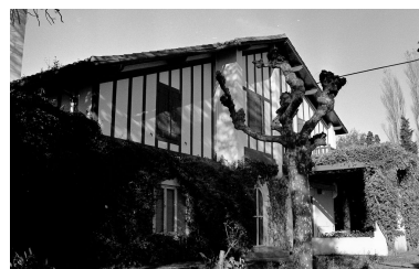
Vue de la façade sud, en 1994. Phot. Pierre-Jean Harté-Lasserre IVR72_19996400122Z
