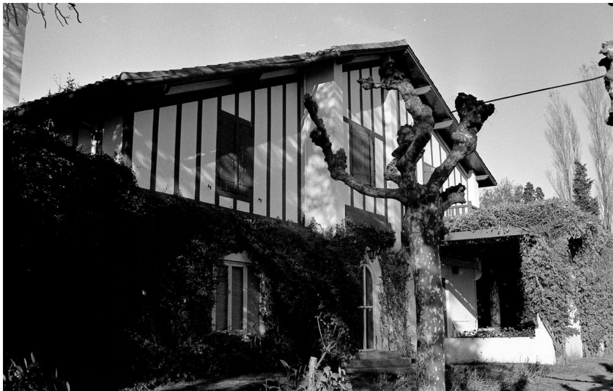
Vue de la façade sud, en 1994.
