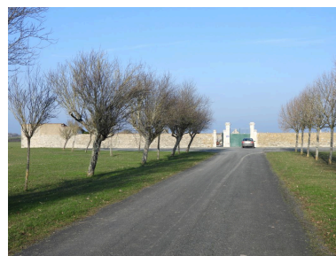
Le cimetière vu depuis le sud. Phot. Yannis Suire IVR75_20201701370NUCA
