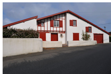
Maison Escolachume, rue Eskola, façade est. Phot. Maïté Ehlinger IVR72_20196403977NUC2A
