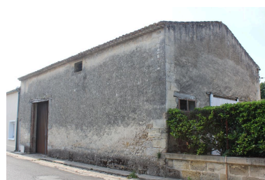
Dépendance. Phot. Claire Steimer IVR72_20163301773NUC2A
