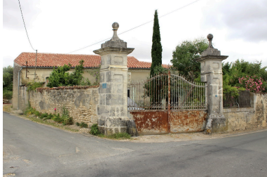
Une vue d'ensemble. Phot. Pierrick Barreau IVR54_20171702805NUCA
