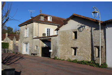
Une vue d'ensemble. Phot. Pierrick Barreau IVR54_20161710411NUCA
