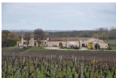
Vue d'ensemble. Phot. Caroline Bordes IVR72_20123300582NUCA
