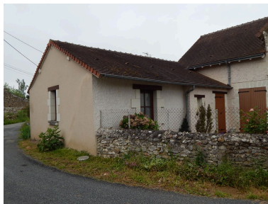
Vue de l'ancienne dépendance depuis le sud. Phot. Paul Maturi IVR75_20198606038NUCA
