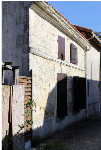
Une vue de la première maison, depuis le nord-ouest. Phot. Nathalie Lhuissier IVR54_20171711441NUCA
