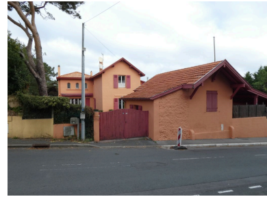
Vue de l'ancienne conciergerie depuis le sud. Phot. Maïté Ehlinger IVR72_20186401953NUC2A
