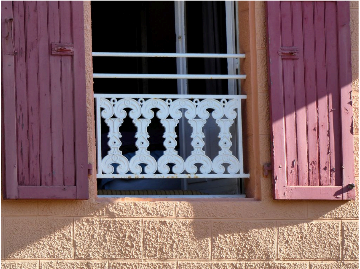
Façade sud, détail du garde-corps.
