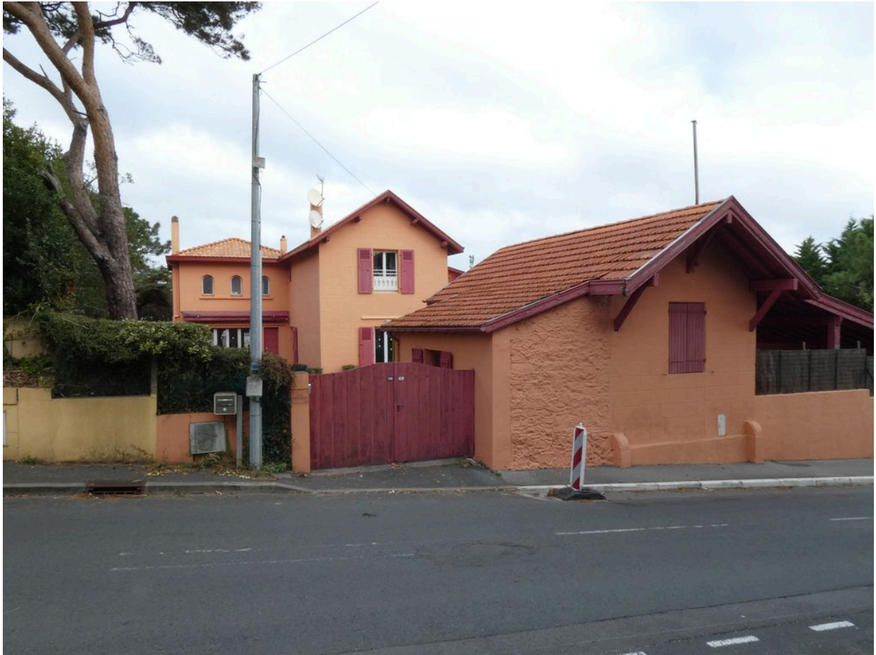
Vue de l'ancienne conciergerie depuis le sud.
