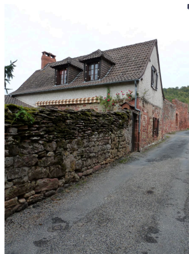
Vue générale sud-est. Phot. Agnès Brahim-Giry IVR74_20091901037NUCA
