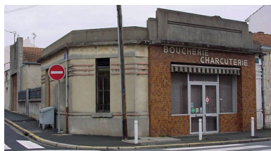
Vue générale. Phot. Claire Peyron IVR54_20041703837NUCA
