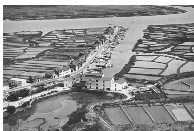
Vue aérienne prise du sud ouest. Ph. studios Bruel et Cie, Angers. Phot. Marc Deneyer IVR54_19971701081X
