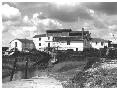
Vue prise du nord est. Phot. Marc Deneyer IVR54_19971701083V
