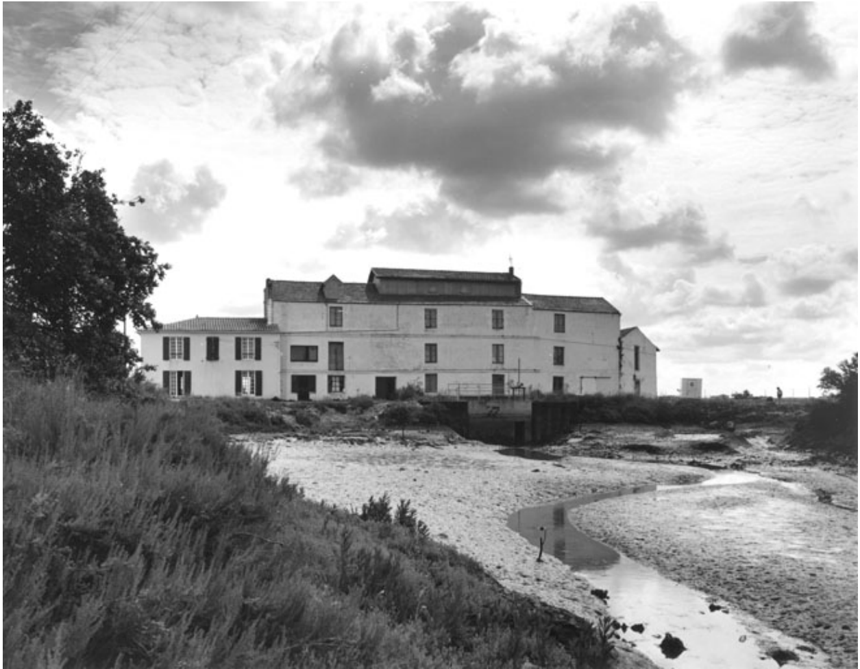
Vue prise de l'ouest.
