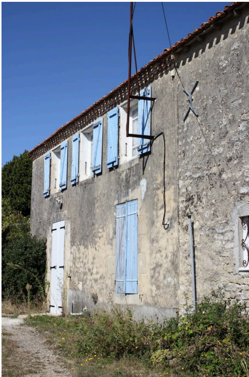
Une vue du logement de l'ancienne ferme, depuis l'est.
