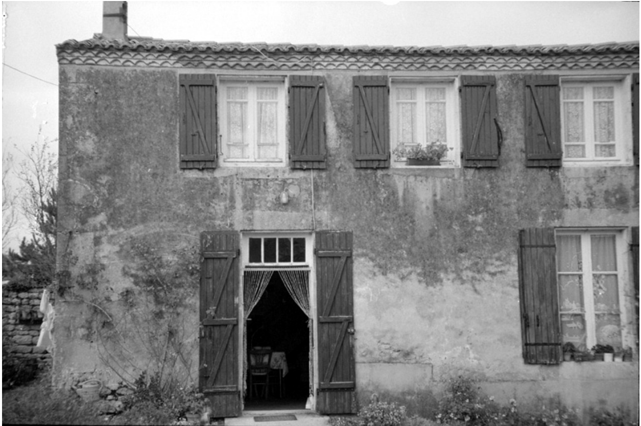
Le logement de l'ancienne ferme, depuis le sud.
